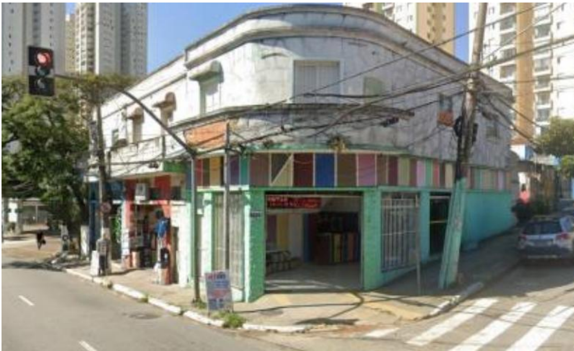
Imagem extraída do relatório fotográfico de 01º de agosto de 2024, demonstrando a existência de comércios no piso térreo e residências no piso superior.
