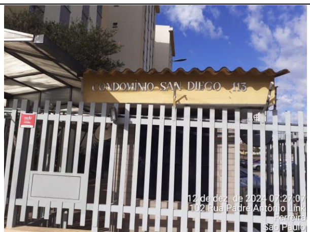
Foto 34 – Rua Padre Antônio Link, 113.
