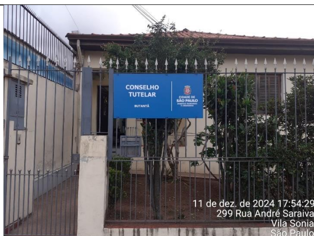
Foto 21 – Rua André Saraiva, 300.
