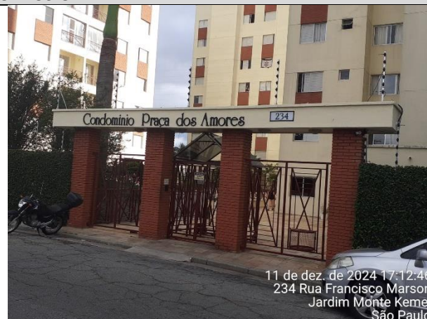
Foto 26 – Rua Francisco Marson, 234.
