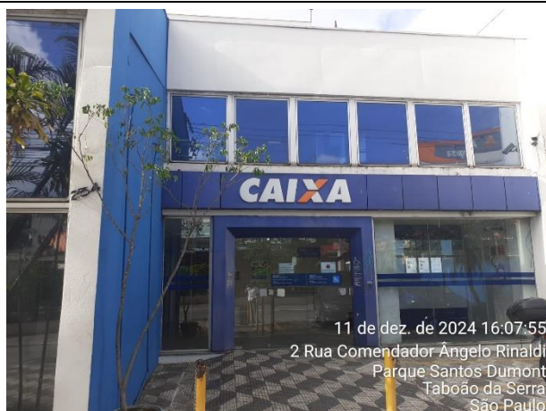
Foto 57 – Rua do Tesouro, 254.
