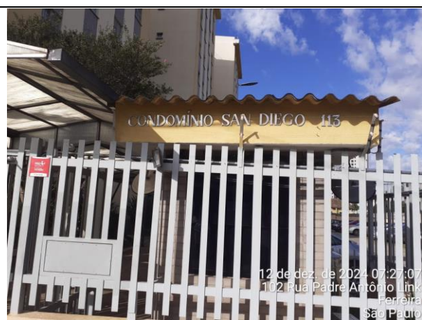
Foto 34 – Rua Padre Antônio Link, 113.
